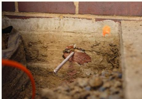
Die weitere Verlegung des Glasfaser-Kabels erfolgt nun durch den bereitgestellten Leitungsweg, der durch Sie oder einem von Ihnen beauftragten Techniker vorbereitet wurde.
